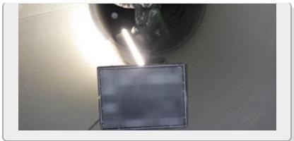
溶接後のガスダクトの内部をタッチアップ塗装して、耐久性を向上させます。
